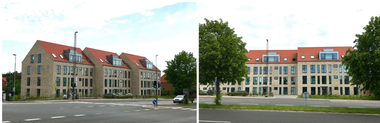
Eksempel på nyt byggeri langs Skanderborgvej i en passende højde med saddeltag. Byggeriet ligger Skanderborgvej 159. Arkitekt, ArcNordic Arkitekter & Ingeniører.
